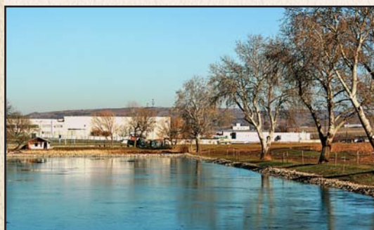
Práce na rybníku dospěly do finále, rybník je vyčištěný, břehy nově osázené mladými stromky, nastupující hladina čeká už pouze jen na první ryby.
